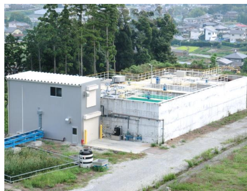
掛川工場排水処理設備
